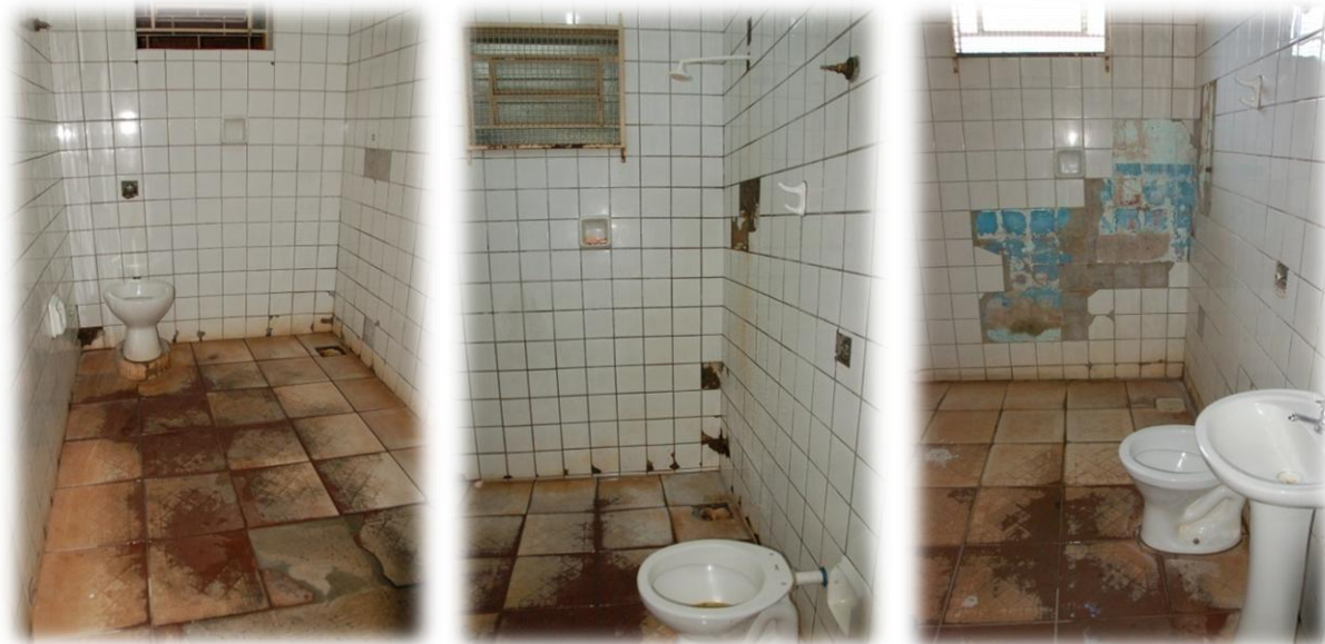
Banheiros do Hospital Adauto Botelho
