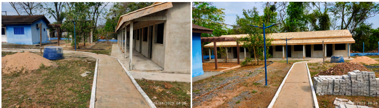
Hotel de Trânsito em Cuiabá (ampliação da capacidade de hospedagem)
